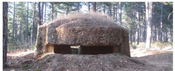
Posición El Pinar 2. Las piedras y la tierra colocadas sobre el nido sirvieron de camuflaje a la estructura. Position El Pinar 2. The stones and earth placed over the nest served as camouflage.
